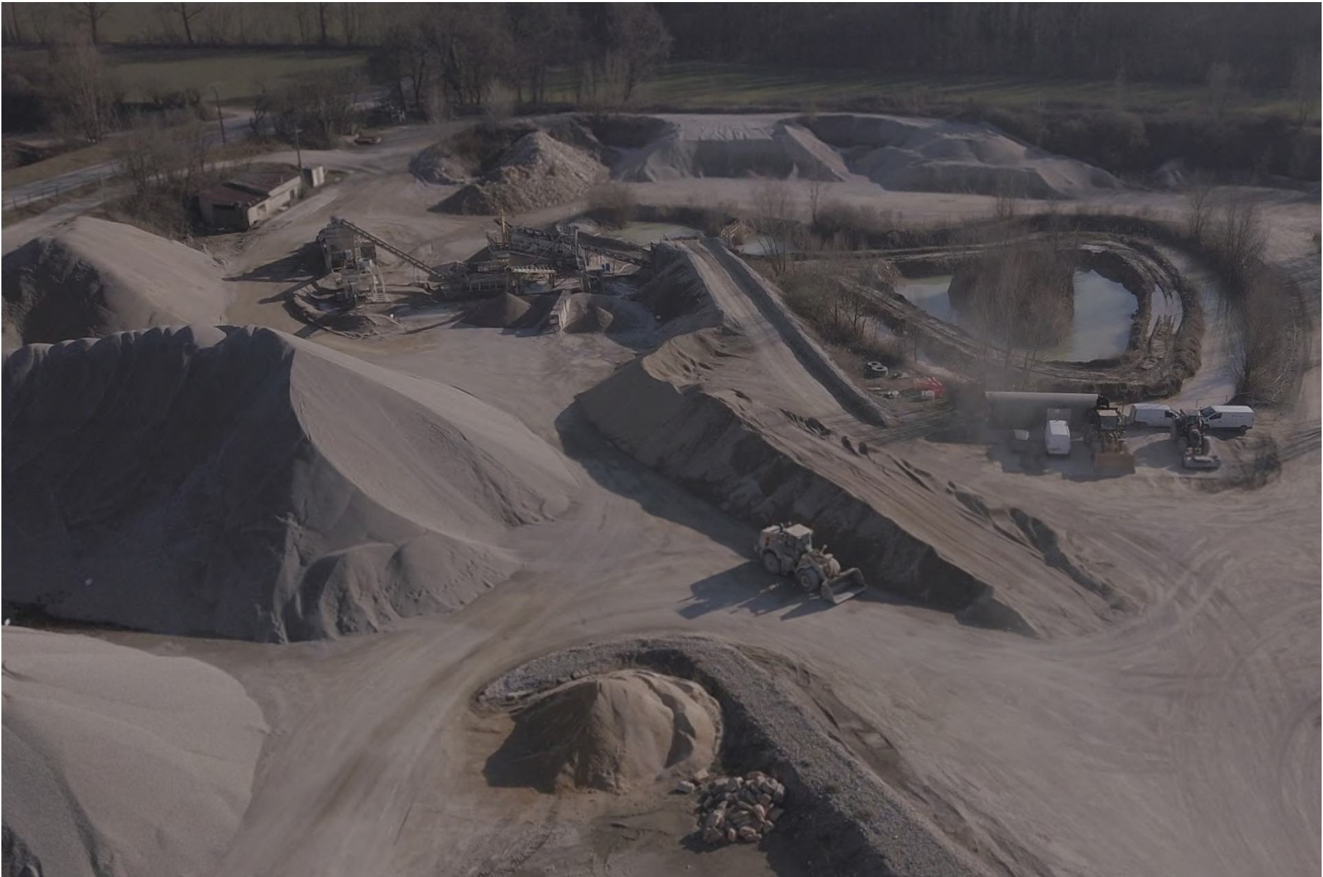
Vue aérienne oblique de l'installation
